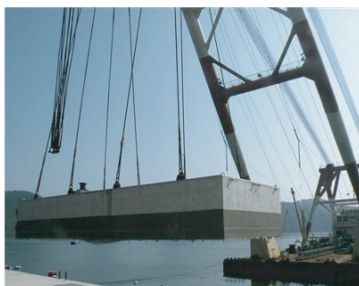
당항포마리나 부방파제 시공
